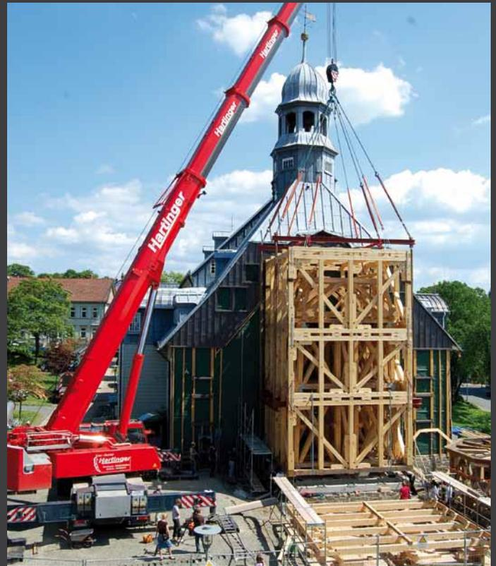
Darüber hinaus stellen wir in konventionellem Abbund Dachkonstruktionen, Türme und Gauben sowohl zum örtlichen Aufbau als auch in Fertigteilen zur Kranmontage her. Weitere Arbeitsgebiete sind die Fassadenbekleidung und der Innenausbau.
